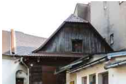
Dům č. 175 v Rožnově, zbytky roubení na zadní straně domu, foto J. Kolář, 2021
